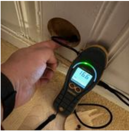
Hulltaking med fuktmåling i utførende yttervegg under terreng (soverom) viser fuktverdier under grenseverdier på fukt på 20%.
