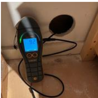
Hulltaking med fuktmåling mot våtsone uten avvik målt fra tiliggende bod.
