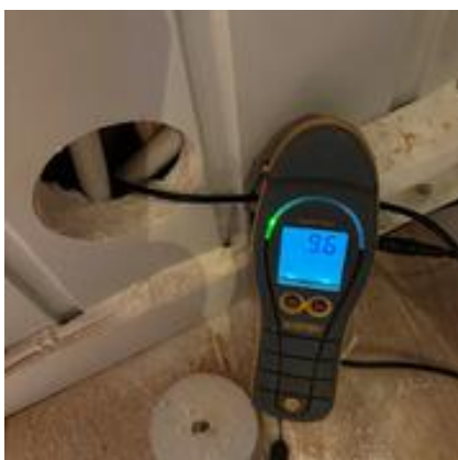
Hulltaking med fuktmåling mot våtsone uten avvik målt fra tiliggende gang.
