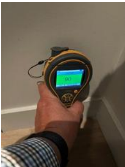
Fuktmålinger fra tilleggende rom mot våtsone (gang) viser normale fuktverdier.
