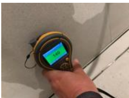
Fuktmålinger på våtroms overflater viser normale fuktverdier.
