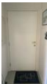
Inngangsdør med brannklasse B30
