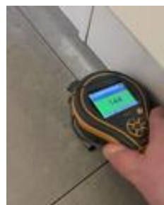
Fuktsøk på gulv ved installasjoner for vann.
