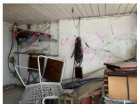
Støttemur i u. etg.
