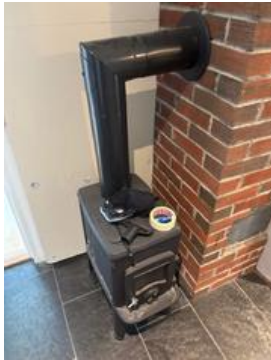
Vedovn plassert i gangen i 1 etg.
