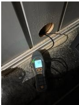
Hulltaking med fuktmåling mot våtsone uten avvik målt fra tiliggende vegg under trapp.
