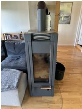
Vedovn plassert i stuen.
