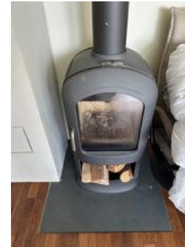
Vedovn plassert i kjølerstue.
