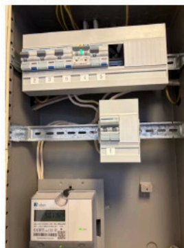
Sikringskap med automatsikringer plassert i felles trappoppgang.
