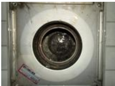
Blucher stålsluk med skrudd slukrist i dusjsone
