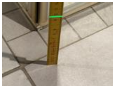
Fallforhold ca. 116 mm overkant gulv ved dusjsone
