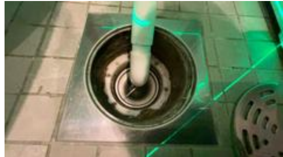
Kontroll av sluk.
