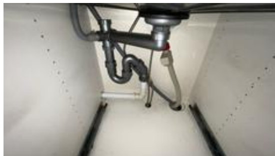
Besiktigelse av rørøpplagg.
