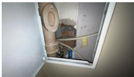
Besiktigelse av rørøpplagg.
