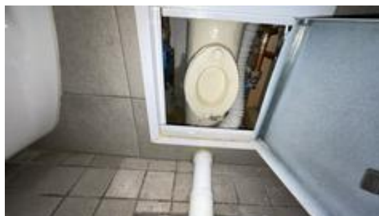
Besiktigelse av rørøpplagg.
