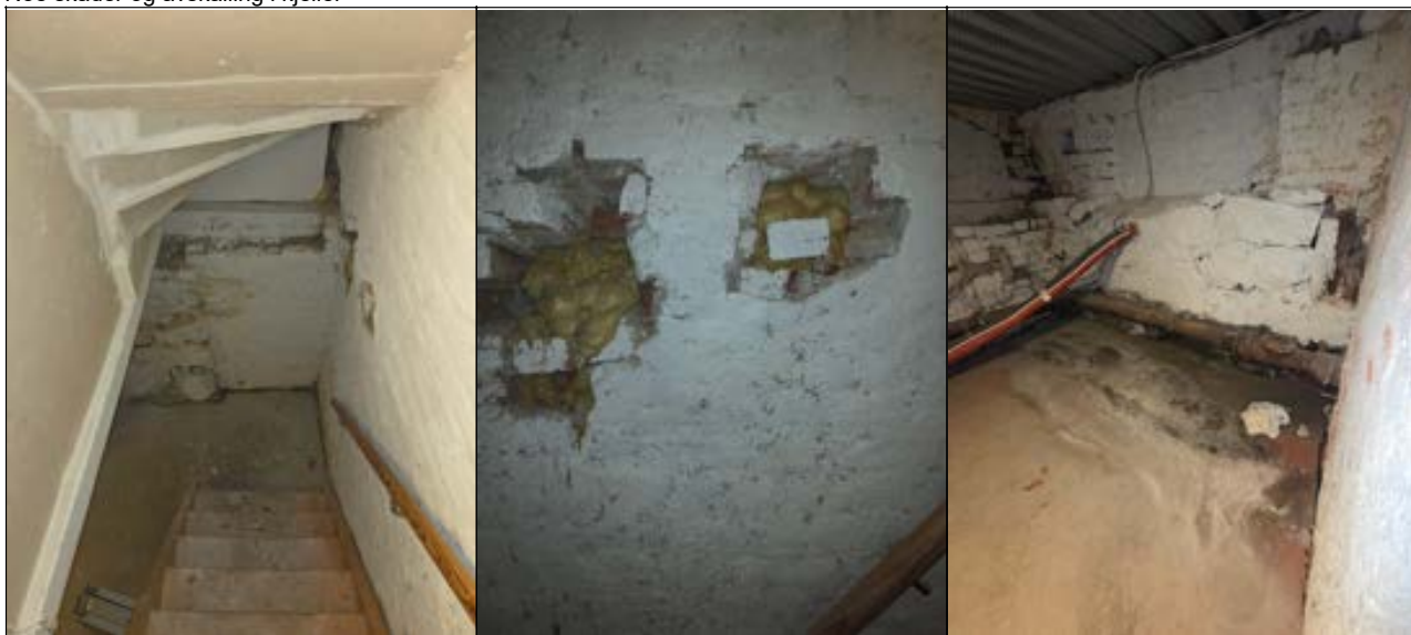
Bygg B Noe skader og avskalling i kjeller
