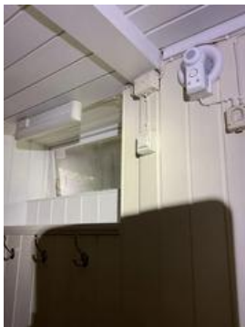
Det er elektrisk vifte i yttervegg på bad, men utover dette er det åpning av vinduer som er luftemulighet.
