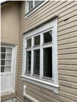
Det er ikke benyttet beslag på vannbrett til vinduer.
