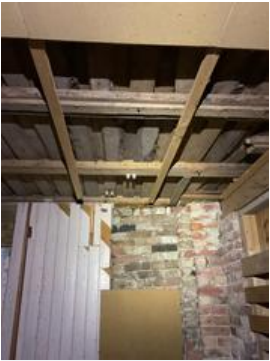
Bjelkelag med stubbeloft og trolig koks som isolasjon.
