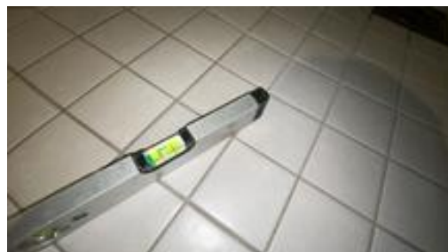
Fallforhold målt i retning sluk.
