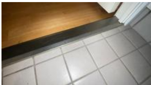
Overgang ved dørterskel.
