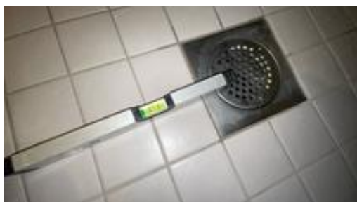
Fallforhold målt i retning sluk.
