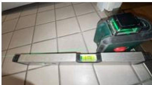
Fallforhold målt i retning sluk.
