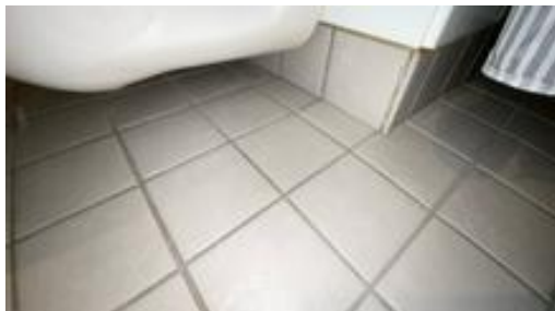
Ikke synlig dreusspalte under toalettet.
