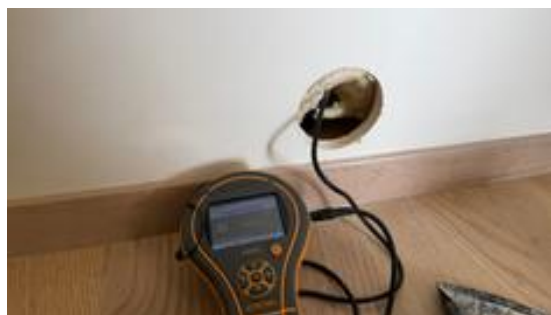
Bilde viser hvor det ble utført hulltaking og fuktmåling i vegg mot våtsone. Det ble montert blindlokk for å dekke til hullet.
