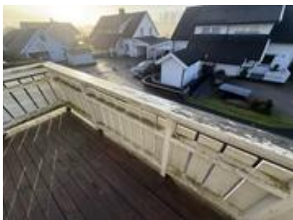
Malingsavflassing på rekkverk.
