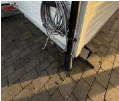
Takvann er ført ned i dreneringsrør i terrenget.
