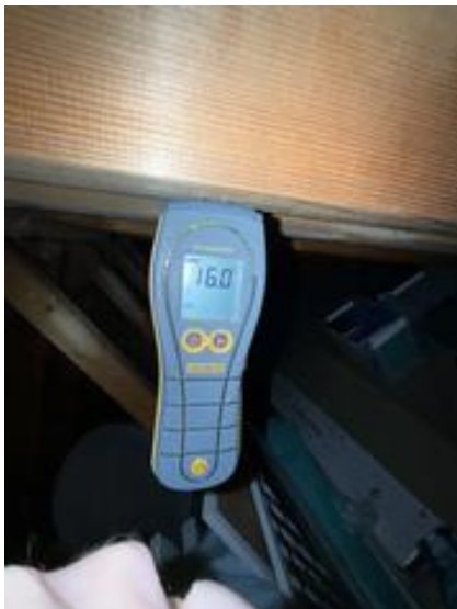
Fuktmåling i undertak.
