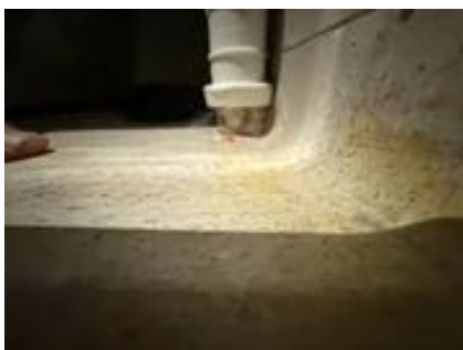
Belegg er ikke ført opp på rørgjennomføring.
