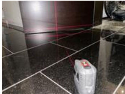
Nivellering trapperom + bod, ingen avvik registrert
