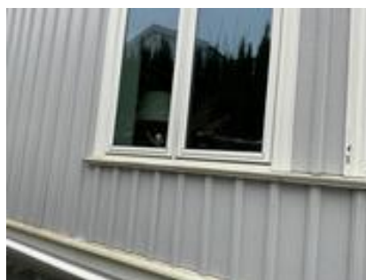
Avflassing av maling samt mangelfull vask mm.
