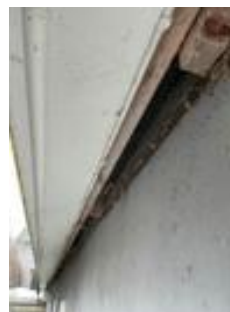
Avflassing av maling samt mangelfull vask mm.
