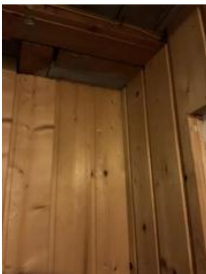
En side av pipe er kledd igjen i kjeller.
