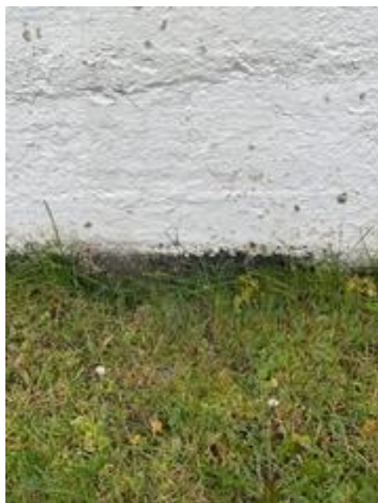
Opprinnelig Goudron er synlig på mur.
