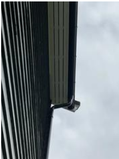
Luftespalter i gesims.
