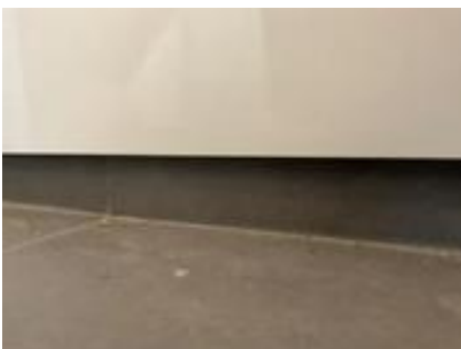
Bunn av baderomsplater uten bruk av skinne eller fug.
