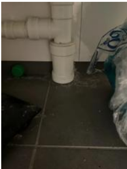
Ukjent tetting av rørføringer under servantskap.
