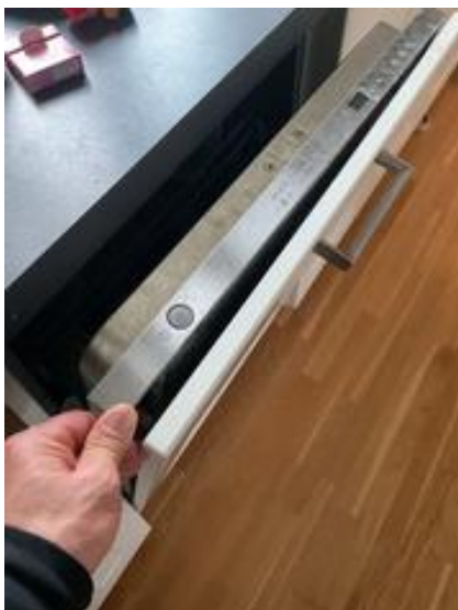
Løs front til oppvaskmaskin.
