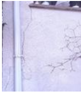
Skrående sprekk i grunnmuren.
