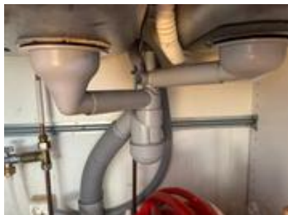
Avløpsrør i underskap vask på kjøkkenet.
