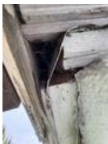
Eksempel på hvor det ikke er etablert gnagersperre ved hjørnekasse.
