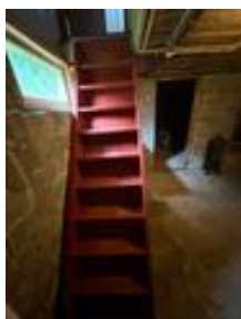
Overiktsbilde av trappen i kjeller.
