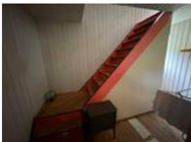
Oversiktsbilde av trappen i 1. etasje.
