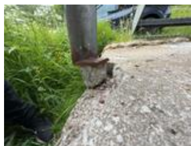
Eksempel på innfesting av søyle som er løsnet.
