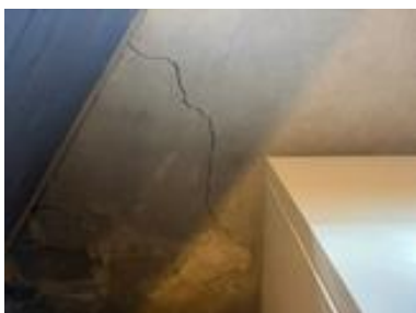
Eksempel på sprekk i grunnmur.
