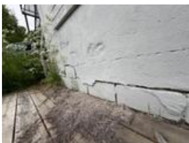
Eksempel på murpuss som mangler.
