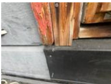
Eksempel av omramming som støter mot vannbrettbeslaget.
