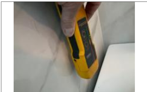
Kontrolløk med fuktmåler.
