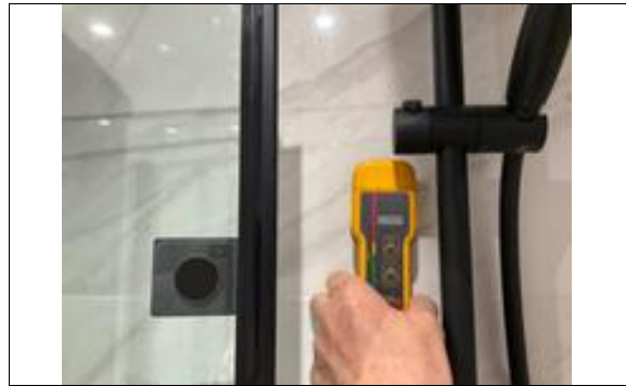
Kontrolløk med fuktmåler.
