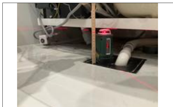
Kontroll av fall på gulv på bad 1
