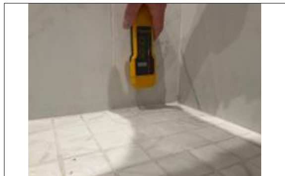
Kontrolløk med fuktmåler.
