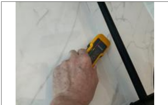
Kontrolløk med fuktmåler.
