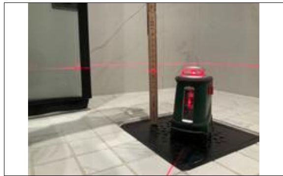
Kontroll av fall på gulv på bad 2
