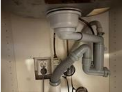
Avløpsrør i underskap vask på kjøkkenet.
