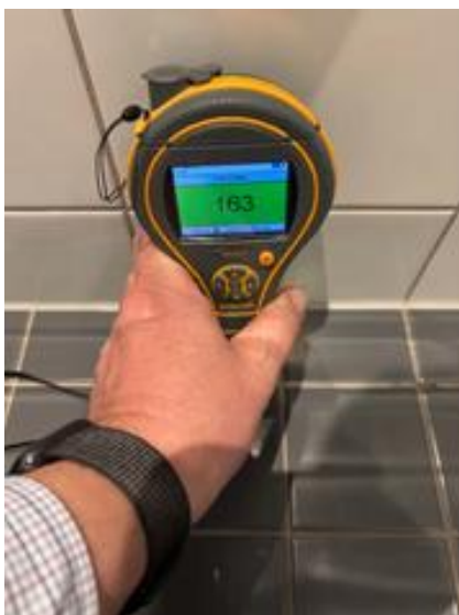
Fuktmålinger på overflater til bad/vaskerom, og fra tiliggende rom viser normale fuktverdier.
