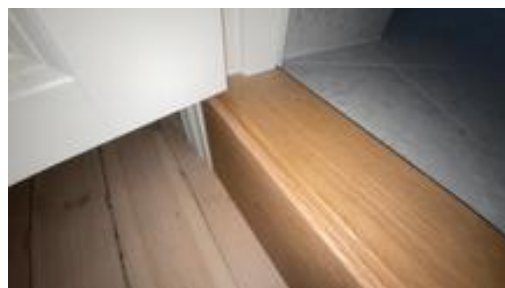
Luftespalte under dørrbladet.
