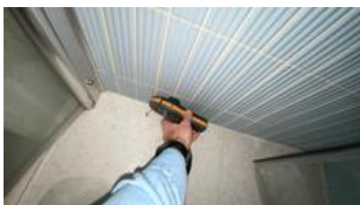
Fuktsøk med Protimeter fuktapparat.
