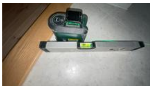
Fallforhold målt i retning sluk.
