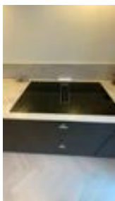
Ventilator med kullfiltervifte i koketoppen.
