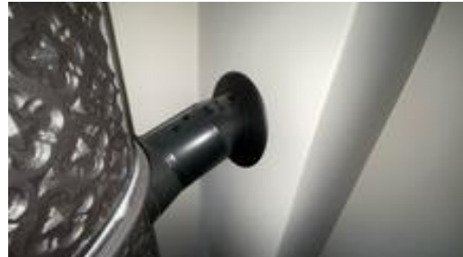
Røykrør og pipeløp. Ingen sprekkdannelser.
