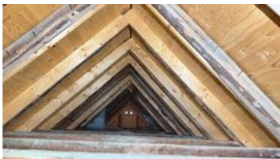
Oversiktsbilde av takkonstruksjon (forsterket) og nyere undertak.
