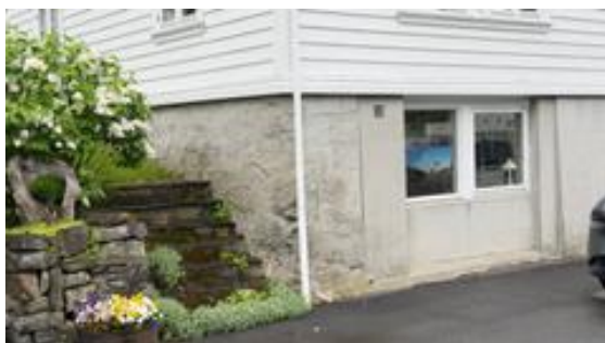
Bilde viser deler av grunnmuren.
