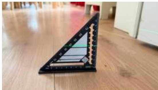
Bildet viser en tilfeldig stikkprøve for å kontrollere skjevheter i gulvet i stue i 1. Etasje. Det ble ikke avdekket vesentlige skjevheter.
