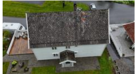
Oversiktsbilde fra drone som viser taktekingen.
