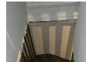
De virker som om grunnmur er forsterket
