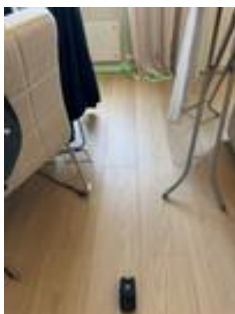
Foto viser nivellering med krysslaser i stue
