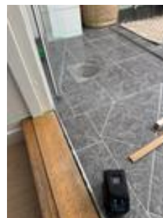
Kontroll med krysslaser av høydeforhold
