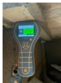
Målt etter fukt i krypkjeller og bjelkelag, ingen unormale verdier i forhold til tid på år og tilstand i krypkjeller.
