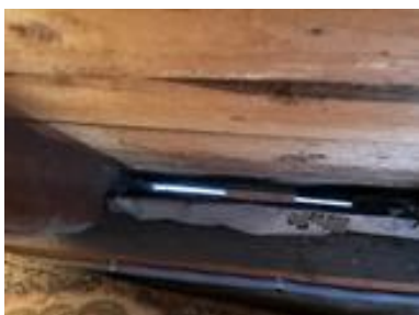
Lufting av takkonstruksjon
