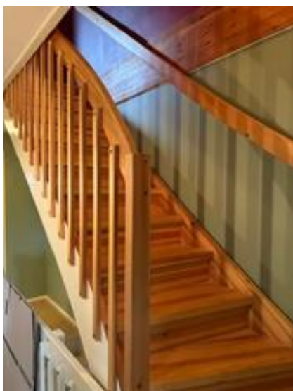
Innvendig trapp til loft er en lukket tretrapp fra byggeår.
