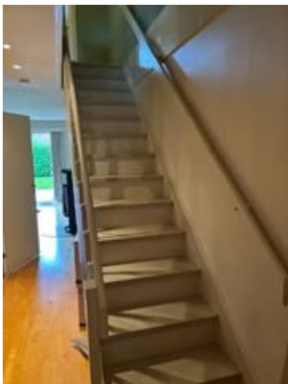
Innvendig trapp til 2 etg er en lukket, malt tretrapp fra byggeår.
