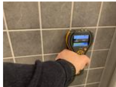
Fuktmåling på overflate i dusjsone
