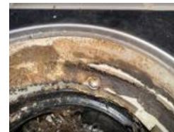
Plastsluk med klemring og synlig membran/mansjett
