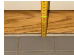
Fallforhold ca. 98 mm overkant gulv ved terskel
