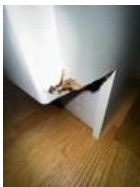
Påvist synlig skade/sår på benkeplater
