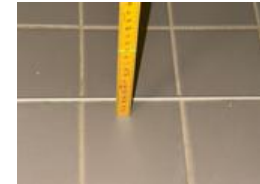
Fallforhold ca. 120 mm overkant gulv ved dusjsone
