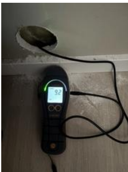
Hulltaking med fuktmåling mot våtsone uten avvik målt fra tiliggende soverom 1.
