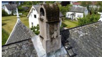
Bilde viser deler av taktekkingen.
