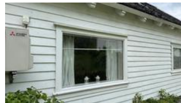
Bilde viser et eldre vindu på boligen.
