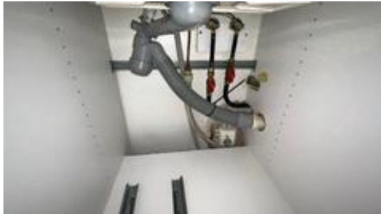
Besiktigelse av røropplegg.
