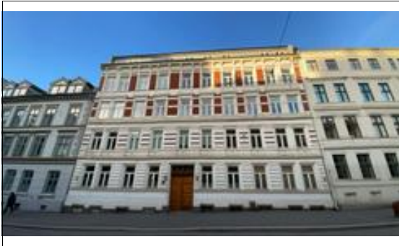
Hovedfasade mot Thereses gate. Felles portrom inn mot felles gårdsrom.
