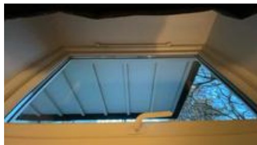
Luftespalte over vinduet.
