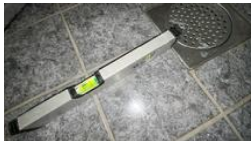
Fallforhold målt i retning sluk.
