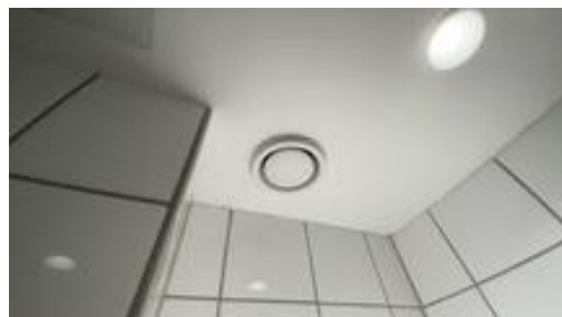
Avtrekkventil
