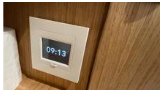
Termostadbryter til varmekabler.
