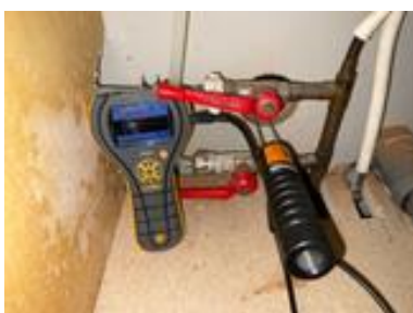
Fuktmåling i vegg ved hulltaking.
