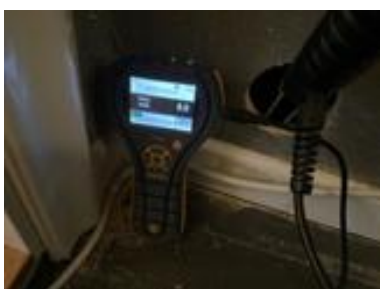
Fuktmåling i vegg ved hulltaking.
