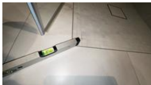
Fallforhold målt i retning sluk.
