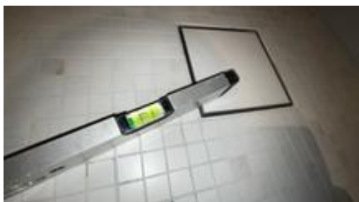
Fallforhold målt i retning sluk.
