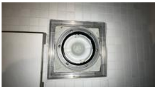
Sluk med klemring.
