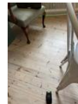
Foto viser nivellering med krysslaser på kjøkken
