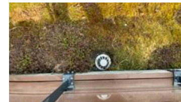
Kontroll av sluk.
