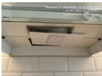
Test av avtrekk
