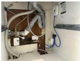
Avløpsrør i underskap vask på kjøkkenet.
