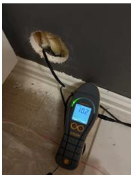
Hulltaking med fuktmåling mot våtsone uten avvik målt fra tiliggende kjøkken.
