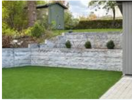
Støttemur oppført i granitt.
