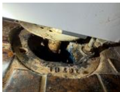
Eldre støpejernsluk i gulv.
