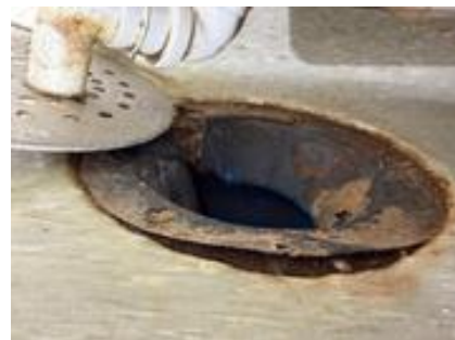
Eldre støpejernsluk i gulv.
