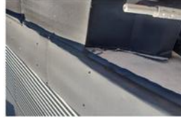
Dårlig håndverksmessig utført takkanalder
