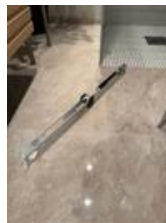
Kontroll av fallforhold med digital vater.
