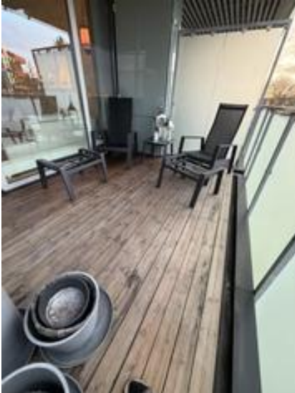
Balkong med adkomst fra stue.
