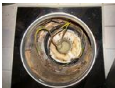
Plastsluk med klemring og synlig membran
