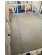
Membran på gulv og varmekabler.
