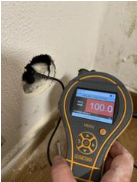
Fuktmåling med pigg.
