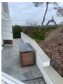
Frittstående støttemur mot naboens hage
