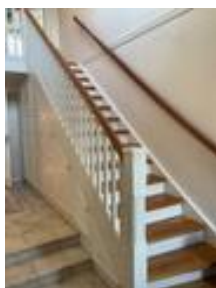
Trapp fra underetasjen til 1. etasje
