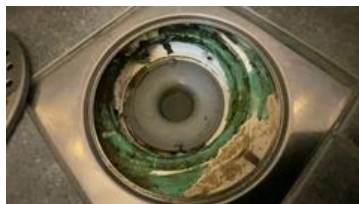
Membran ned i sluk med klemring.
