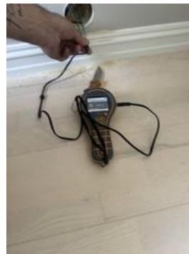
Måler med pigg i treverk mot våtsone på bad i 2. etasje. Måler under 6 vektprosent, hvilket er OK.
