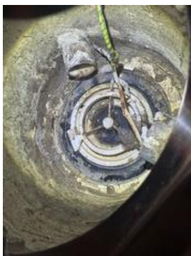
Hovedsluk på bad i 1. etasje
