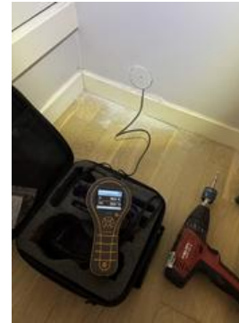
Måler relativ fuktighet mot våtsone på bad i underetasjen. Måler 68%, hvilket er ok.
