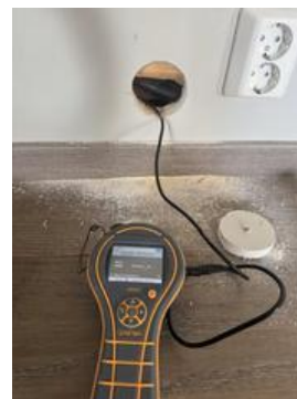
Måler med pigg i treverk mot våtsone på bad i 1. etasje. Måler under 6 vektprosent hvilket er OK.
