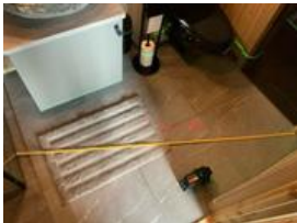
11mm hellning på ca 2mm. Dette tilsvarer 1:200
